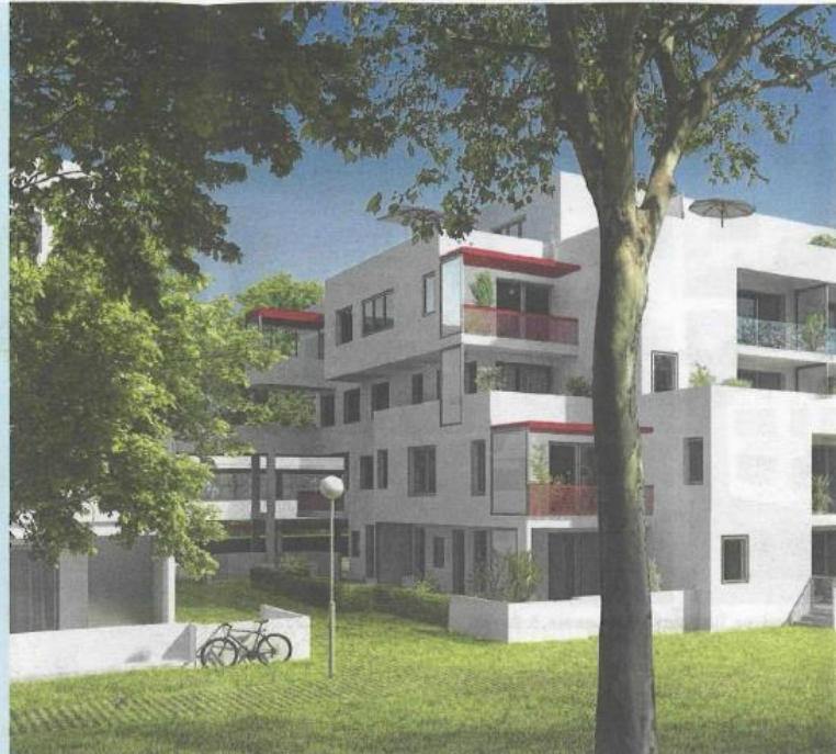
30 Jahre war hier ein Kinder- und Jugendheim untergebracht, nun wurde der Bestand ergänzt und saniert. Ergebnis: eine einmalige Anlage
